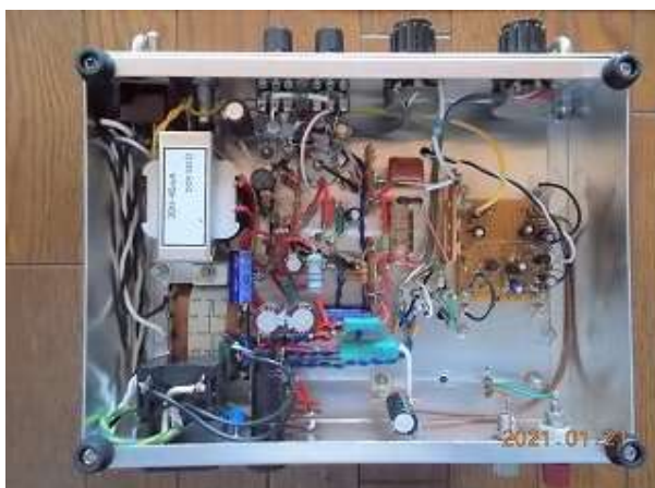
Fig.5-3 配線完了状態
